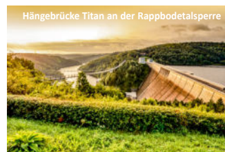
Hängebrücke Titan an der Rappbodetalperre
